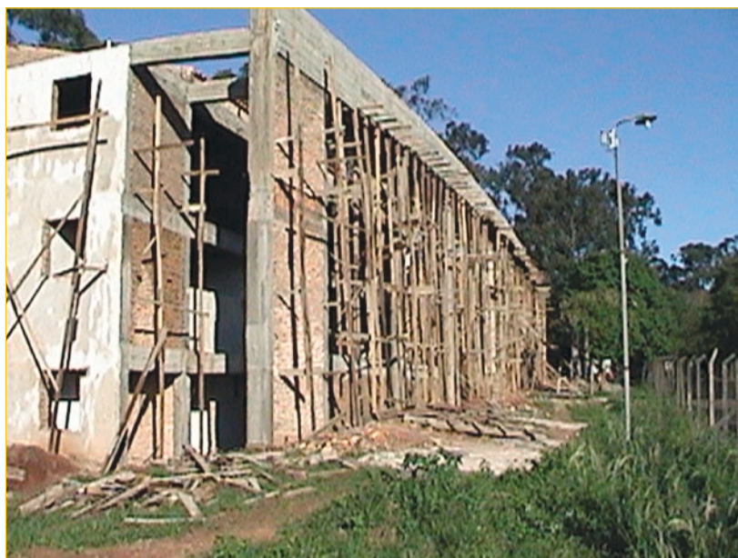
Construcción del Centro de Recursos de Aprendizaje Octubre de 2003
